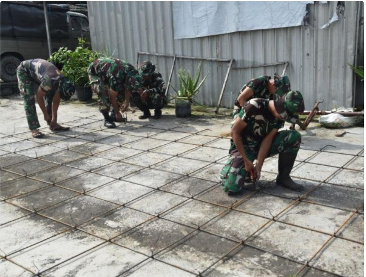
*anggota satgas TMMD rakit besi untuk pengecoran jalan*
